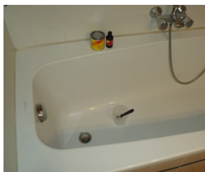
Anti slip laag in een acryl bad
